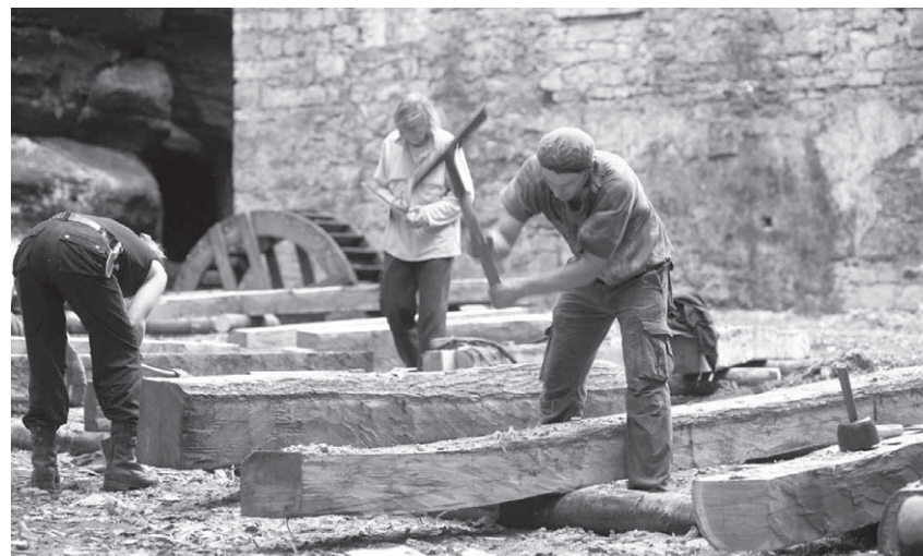
22 Péče o kulturní památku Dolský mlýn v NP České Švýcarsko (výroba dubového roštu do náhonu) / Sanierungsarbeiten am Kulturdenkmal Grundmühle im Nationalpark Böhmisches Schweiz (Herstellung des Holzrosts des Wassergrabens)
