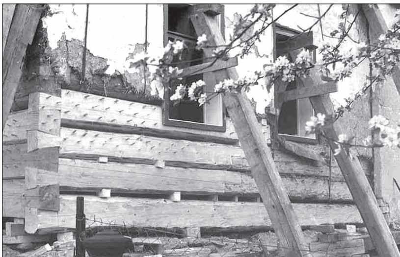
Náhrada celých prvků, nároží roubené chalupy ze začátku 17. stol.
