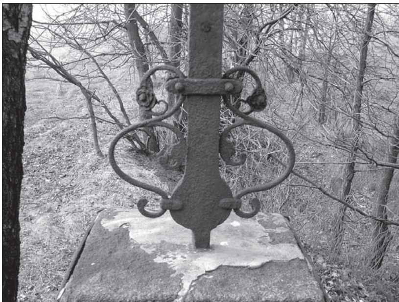
Staré opravy říms narušených korozi zapuštěných částí kříže
