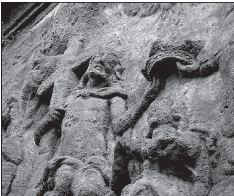
Reliéf Korunování Panny Marie v Srbské Kamenici, detail desintegrovaného pískovce
