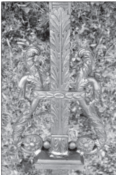
Soklík kříže, lící strana, stav po sejmutí nátěrů v alkalické lázni. Intaktní povrch vysoce kvalitního odlitku, dokonale přepisujícího dřevěný ručně vyřezávaný model. (Tetčiněves, okr. Litoměřice)
