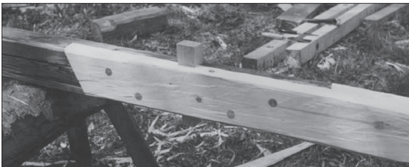
Celodřevěný "nastavovací plát šikmočelný hákový s utahovacím klínem"; tvarově čisté nastavení krokve, vč. sjednocení vzhledu starých a nových lící trámu směrově i rytmicky shodným otesáním šířčinou.
