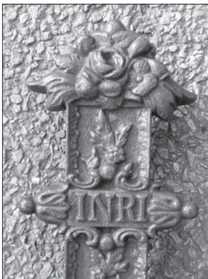
Detail povrchu kříže vyčištěného rotačnými drátěnými kartáči s ručním dočištěním, zbytky nátěrů předem odstraněny v alkalické lázni.
