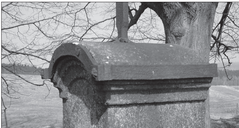
Staré opravy říms narušených korozi zapuštěných částí kříže
