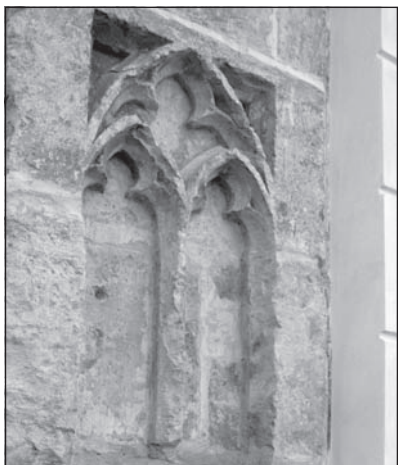
Předšň kostela sv. Petra a Pavla v Bílině (okr. Teplice). Vzácně docho- vaný detail dokládající gotický vývoj byl vážně poškozen až v polovině to- hoto desetiletí, když z něj byly odstra- ňovány mladší historické vrstvy (foto Jiří Varhaník, 2008).
