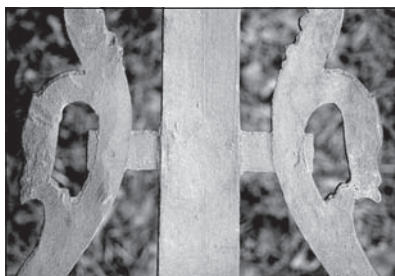
Detail soklíku kříže, rubová strana, stav po sejmutí nátěrů v alkalické lázni. Intaktní povrch vysoce kvalitního odlitku, dokonale přepisujícího dřevěný model včetně konstrukčních detailů a stop po opracování dřeva hoblíkem. (Tetčiněves, okr. Litoměřice)
