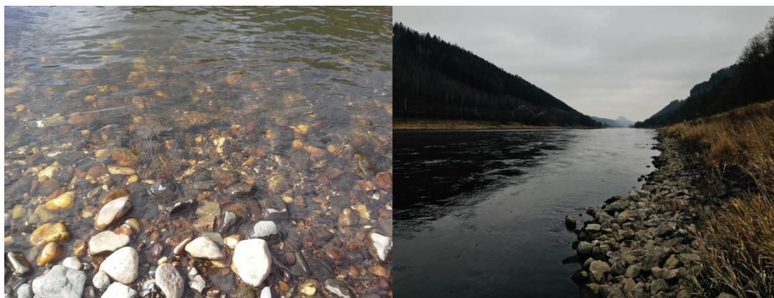
Obr. 2. Úsek říčního koryta opevněného hrubozrnným štěrkem a valouny (vlevo). Úsek koryta opevněného kamenným pohozením (vpravo).
