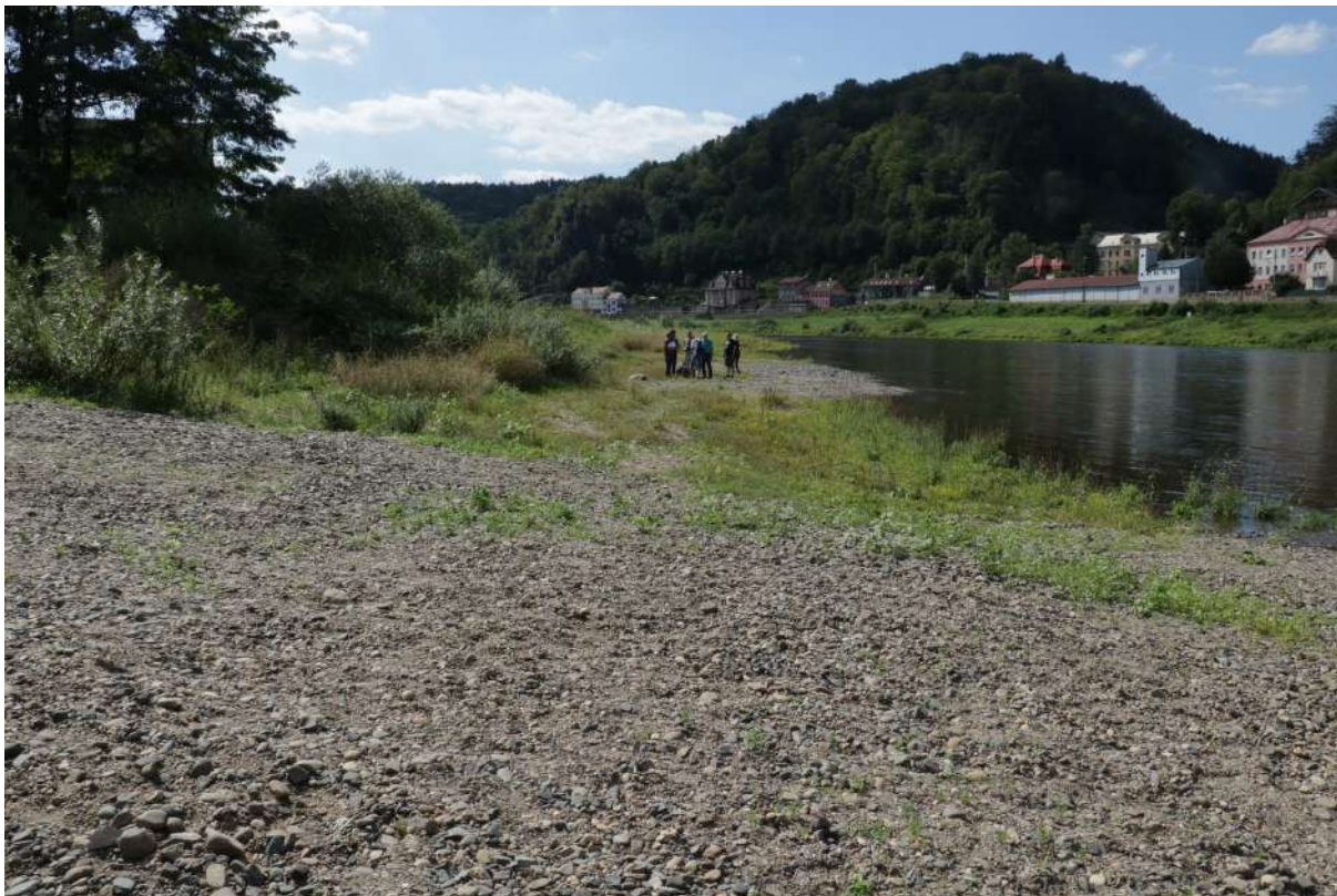
Obr. 16 Stav náplavu po urovnání povrchu, 3. 9. 2019
