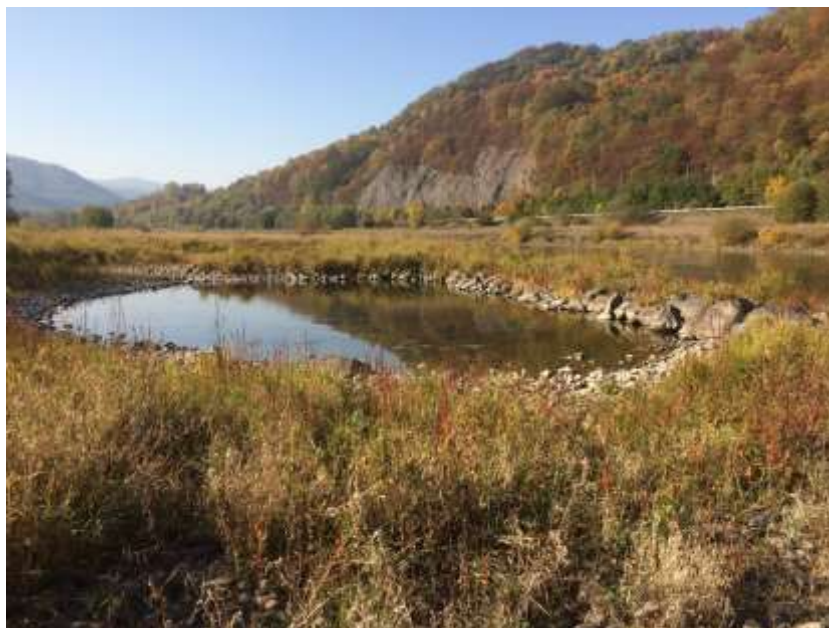
Obr. 5.5: Tůň vytvořené v rámci opatření prováděné na lavici v Malém Březně s využitím kamenného záhozu (pravé části obrázku) na rozhraní mezi hladinou a okrajem lavice (foto směrem proti proudu, Škarpich, V., rok 2018).
