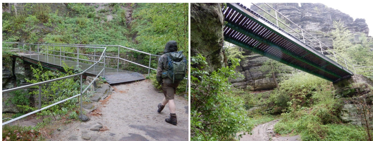
Obrázek 27 – Lávka L03 – Přehledné fotografie
