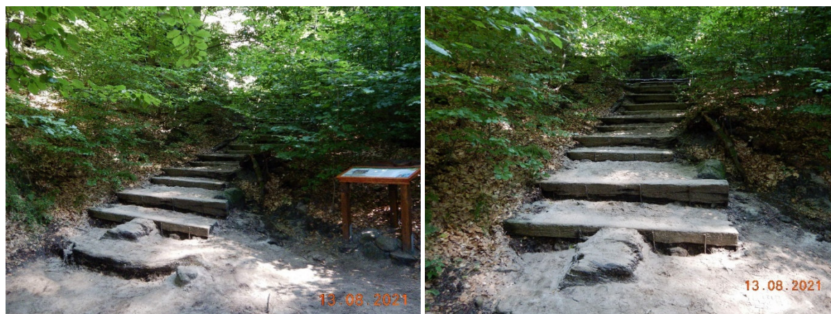
Obrázek 4 – Přístupové schodiště SCH1 – Přehledné fotografie
