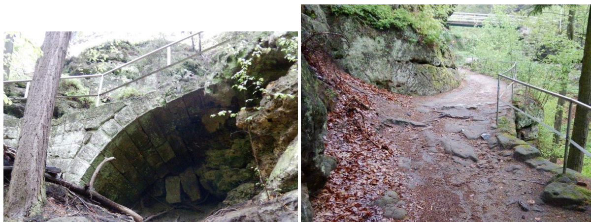
Obrázek 18 – Lávka L01 – Přehledné fotografie
