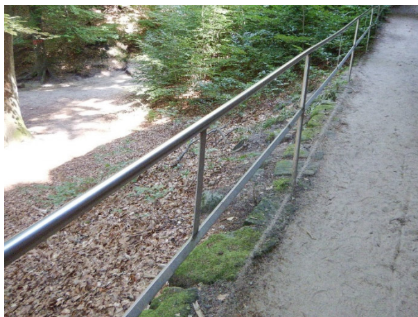
Obrázek 7 – Opěrná zeď OP1 – Uspořádání a typický stav
