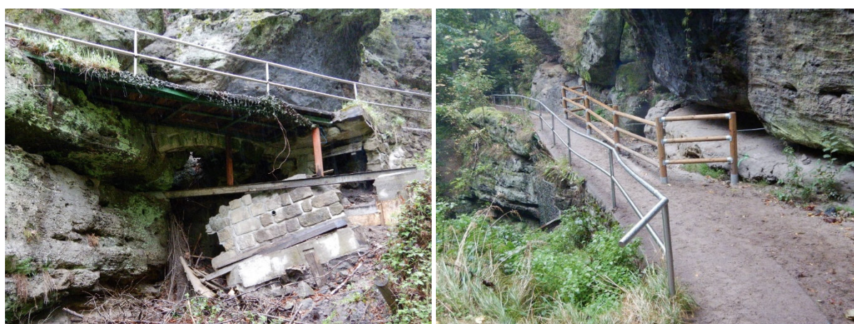
Obrázek 21 – Lávka L02 – Přehledné fotografie
