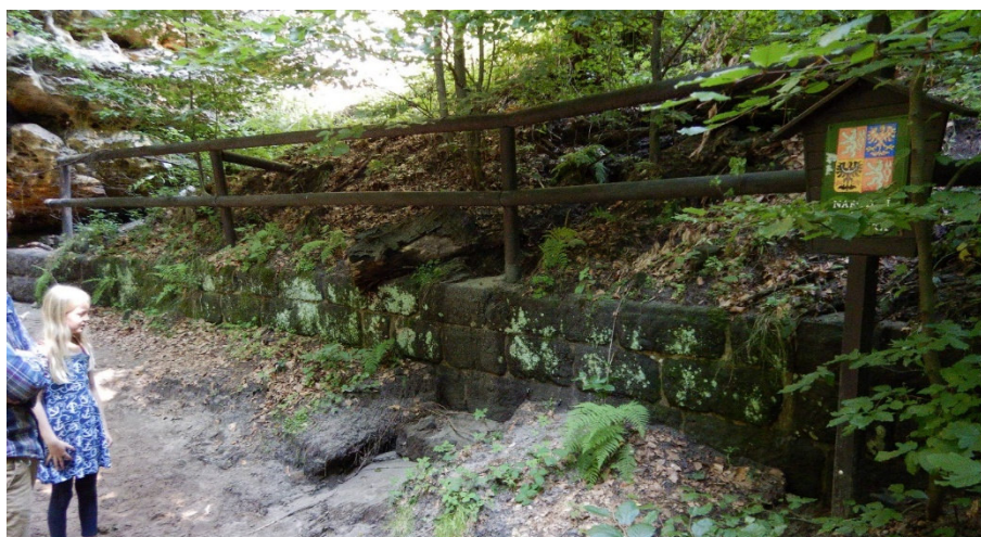
Obrázek 9 – Opěrná zed' OP1 – Přehledná fotografie
