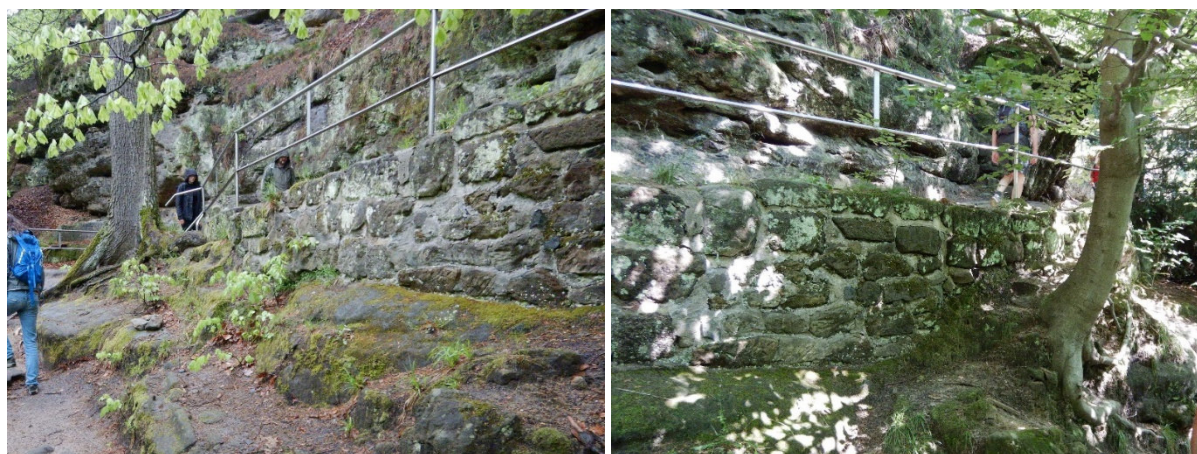
Obrázek 15 – Opěrná zď OP4 – Přehledné fotografie
