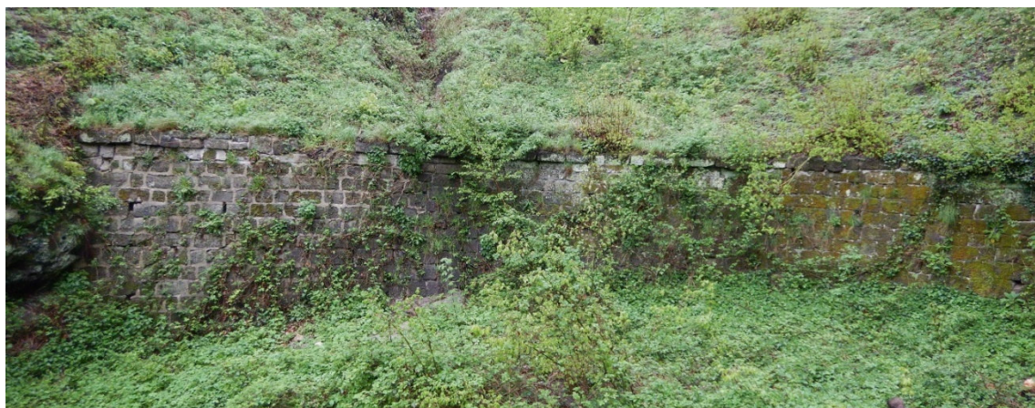
Obrázek 24 – Opěrná zeď OP4 – Přehledná fotografie
