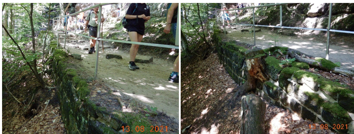
Obrázek 12 – Opěrná zď OP3 – Přehledně fotografie
