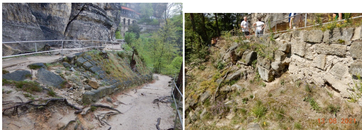
Obrázek 36 – Opěrná zed' OP7 – Přehledná fotografie
