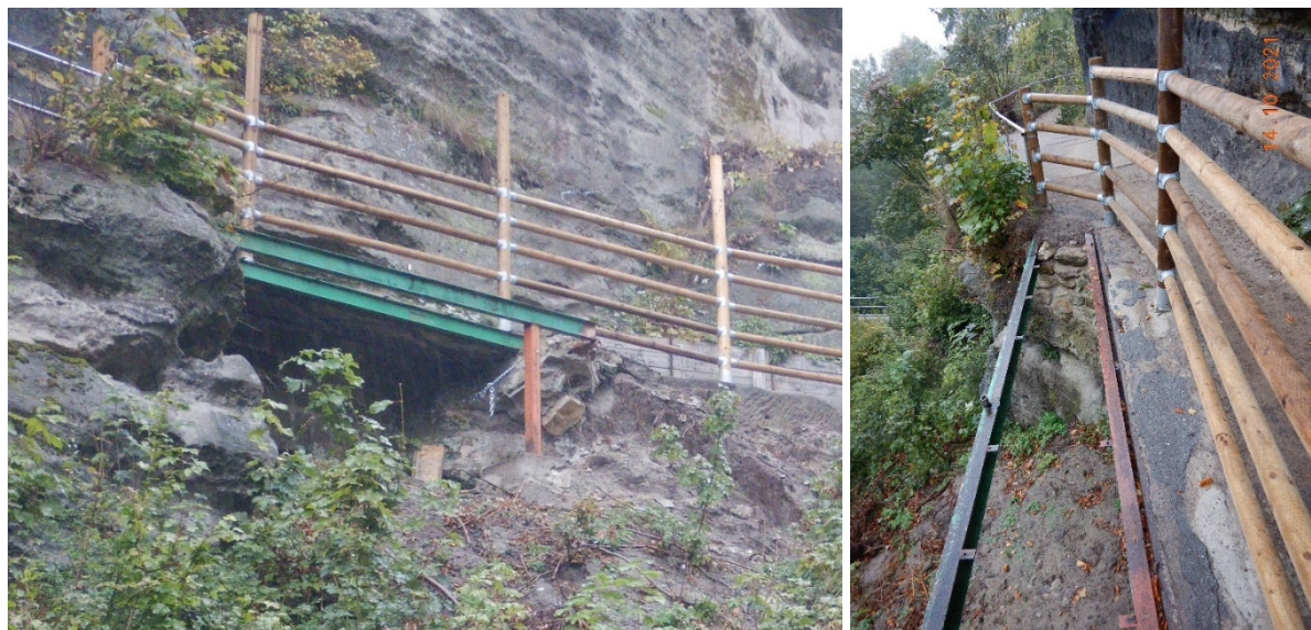
Obrázek 50 – Lávka L08 – Přehledné fotografie
