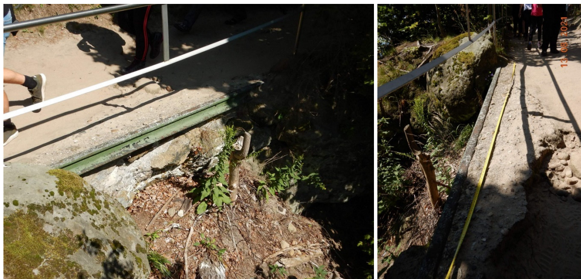
Obrázek 31 – Opěrná zed' OP6 – Typický stav zdi
