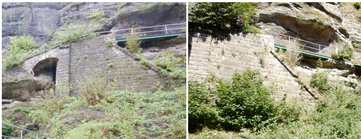
Obrázek 45 – Opěrná zed' OP8 – Přehledná fotografie
