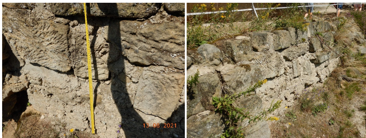
Obrázek 37 – Opěrná zed' OP7 – Typický stav zdi
