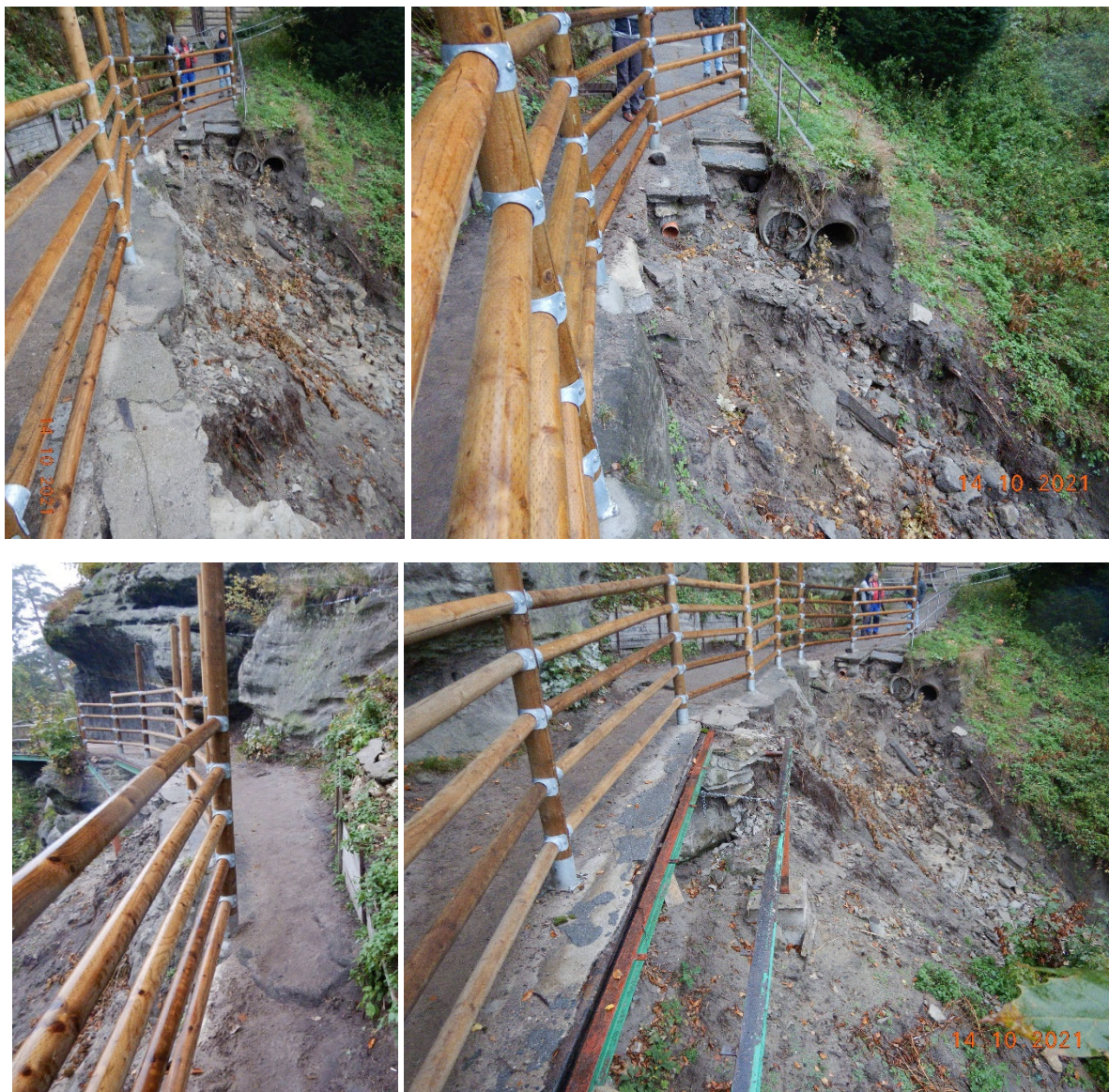
Obrázek 54 – Lávka L09 – Aktuální stav lávky L09 a opěrné zdi OP9
