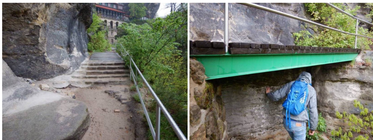
Obrázek 39 – Lávka L05 – Přehledně fotografie
