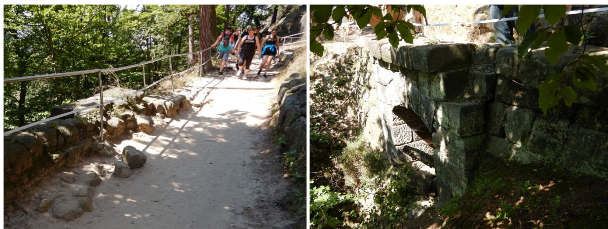
Obrázek 33 – Lávka L04 – Přehledné fotografie
