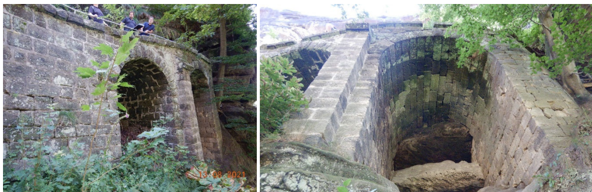
Obrázek 56 – Lávka L10 – Přehledné fotografie
