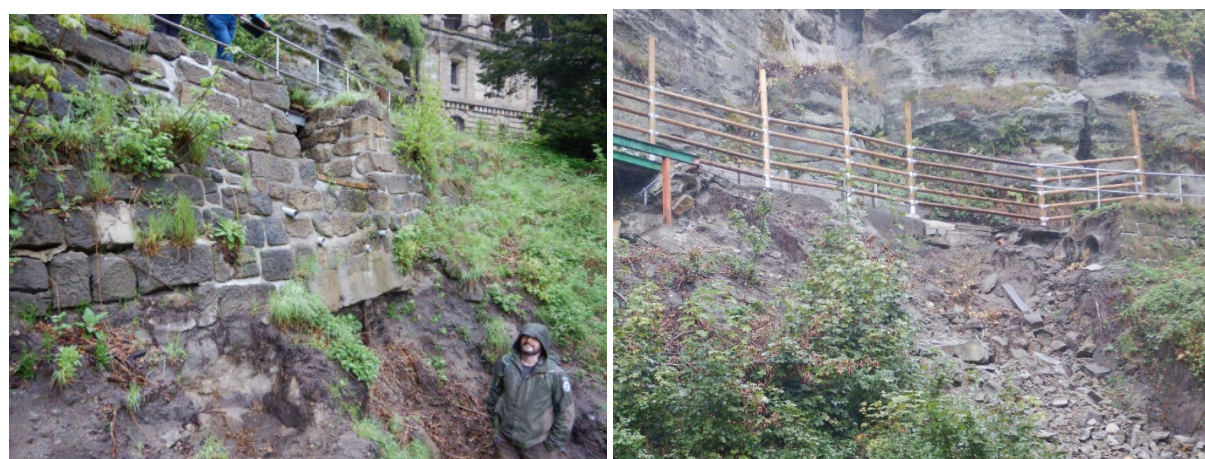
Obrázek 53 – Lávka L09 a opěrná zeď OP9 – Přehledné fotografie – vlevo původní stav, vpravo aktuální stav
