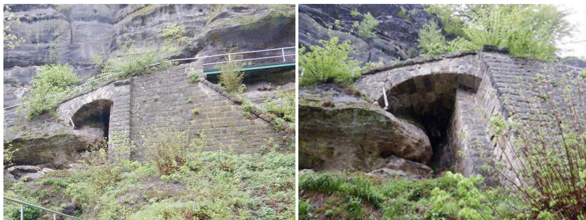
Obrázek 42 – Lávka L06 – Přehledné fotografie
