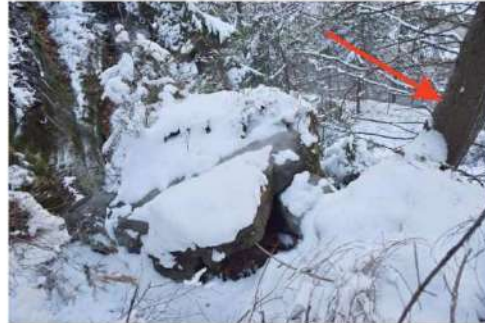
Foto 9 Pohled ze zázemí bloku č. 2. Červená šipka ukazuje na strom, který může iniciovat pohyb vývratem nebo při jeho kácení.
