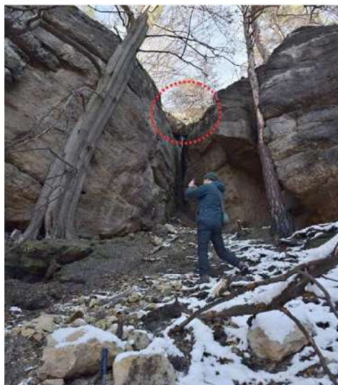
Foto 15 Terénní stupeň skalní stěny, na jehož okraji zůstaly cca 2/3 skalního bloku č. 4.
