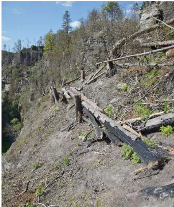
Obr. 26 Pokácené stromy vyskládané po vrstevnici, kde vytváří jednoduchou retardační bariéru. Nad nimi i pod nimi je povrch vystaven erozním účinkům.
