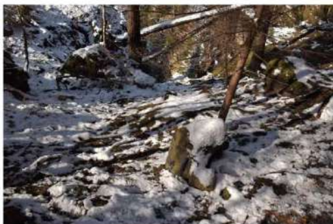
Foto 14 Fragment zřícené části skalního bloku č. 4.
