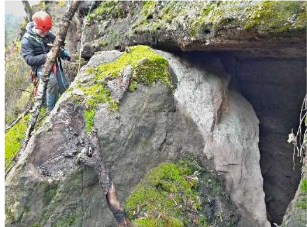
Obr. 18 Zaklínění skalního objektu při stropu převisu je pouze v relativně malé ploše až bodového charakteru.
