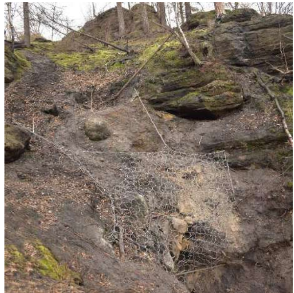
Obr. 7 Objekt č. 4 byl zajištěn kotvenou ocelovou sítí.
