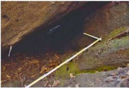
Foto 3 Prostor pod skalním blokem s erozí vypláchnutým zeminovým pokryvem svahu.
