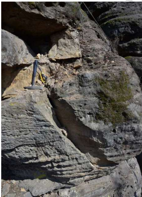
Obr. 19 Světlá plocha s kladívkem je odlučnou oblastí dílčího řícení, pravděpodobně způsobené vývratem nízkého stromu.
