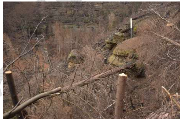
Obr. 12 Kácení bylo provedeno také nad úsekem DD5, na hranách hřebene.
