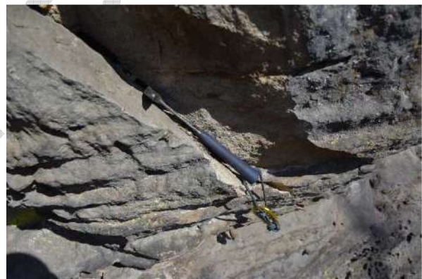
Obr. 20 Objekt vykazuje pohyb posunutí v horizontální rovině (rozevření pukliny).
