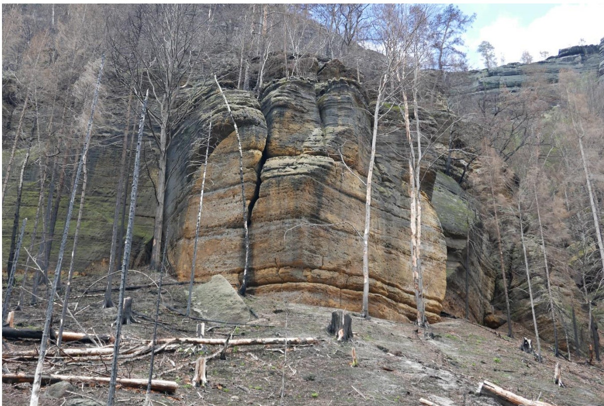
Foto 4: Skalní masivy v Dlouhém dole byly požárem zasaženy nerovnoměrně.
