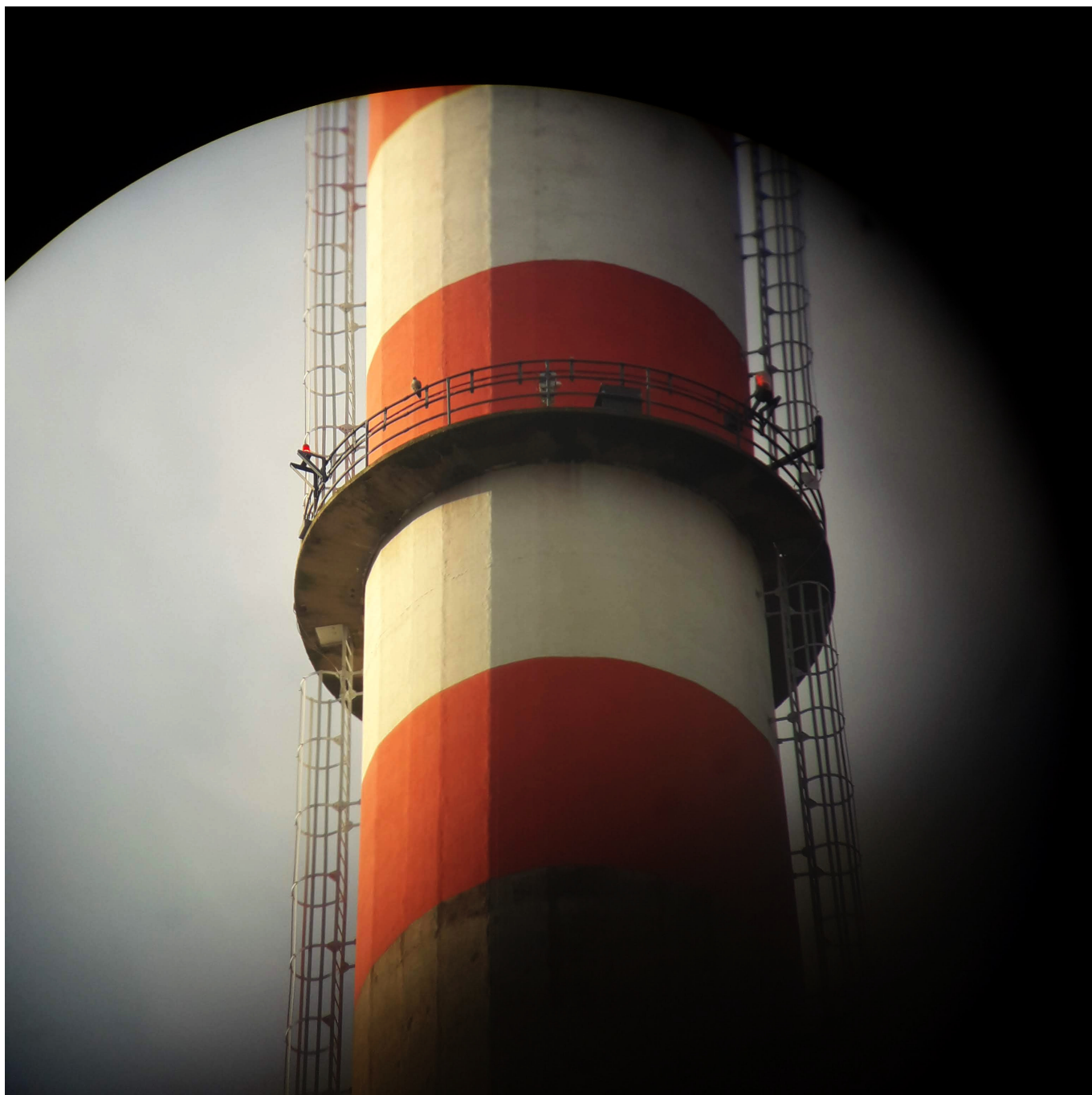
Sokol stěhovavý na zábradlí ochozu komína firmy TERMO Děčín a.s. (foto: Tomáš Salov, mobilním telefonem skrz dalekohled)
