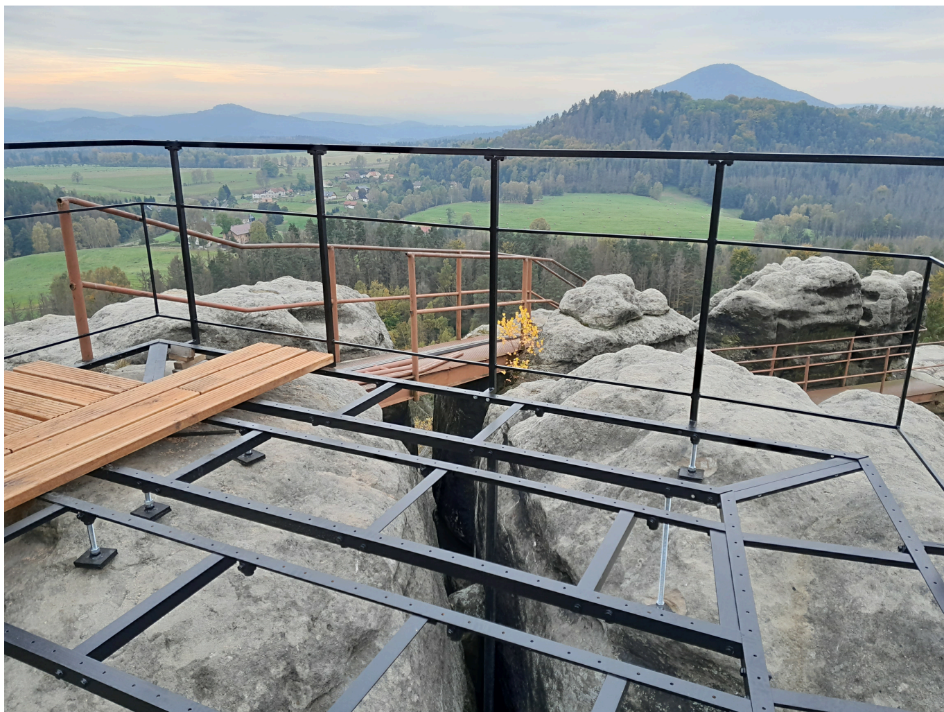
Å aunÅ;tejn bude bezpeÄĚnÄĚji pÅĚstupnÄĚ dÄĚky novÄĚmu systÄĚmu lÄĚvek. StarÄĚ lÄĚvky (na snÄĚmku za novÄĚm zÄĚbradlÄĚm) budou odstranÄĚny. Foto: Pavel Svoboda
