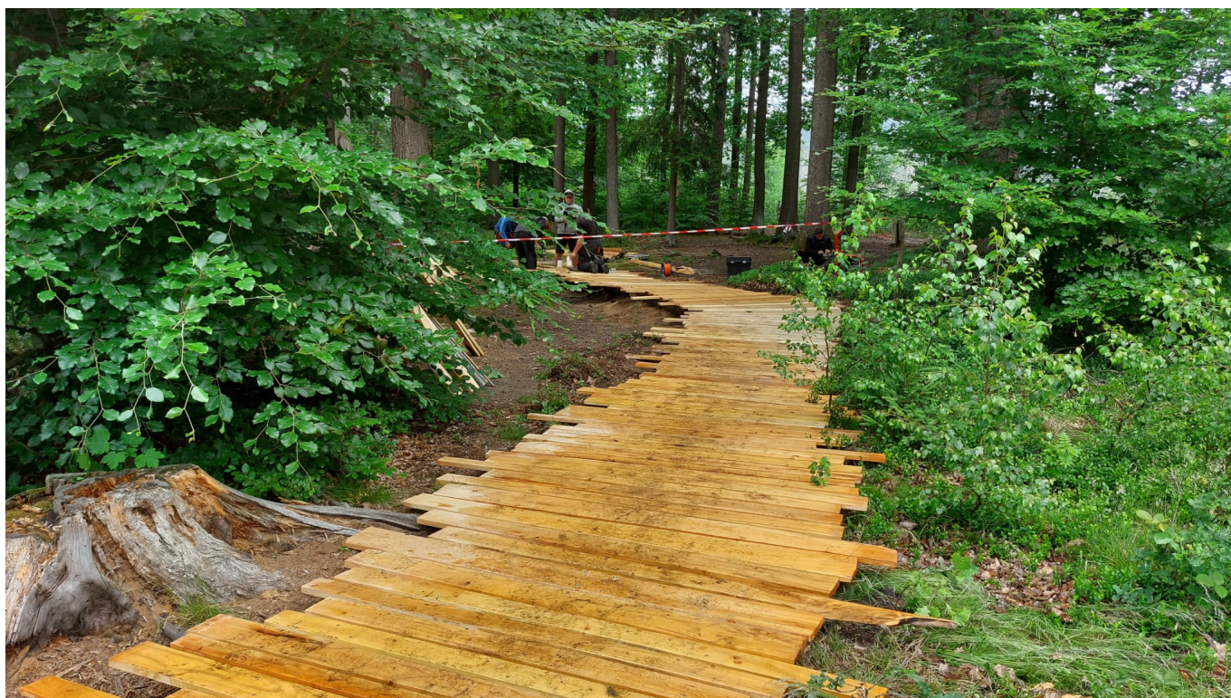
Vznikající dřevěný chodník v areálu Rysí stezky. Foto: Richard Nagel
