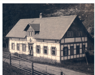
Po pravé straně v blízkosti silnice zřetelná destrukce: DŮM čp. 4
