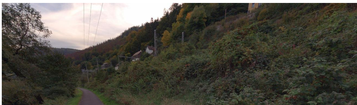
OBRÁZEK 12 SEVERNÍ ČÁST SÍDLA NA LEVÉM BŘEHU LABE PODÉL ŽELEZNIČNÍ TRATI
