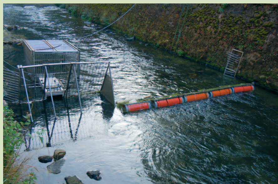
Plovákový navigační plot na Kamenici ve Hřensku. Foto: Miloš Trýzna
