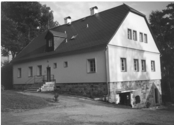
budova LS po rekonstrukci
