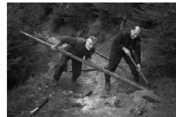
stráž přírody při úpravě erozí poškozené cesty
