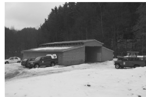
nově budované zázemí lesní správy v Jetřichovicích
