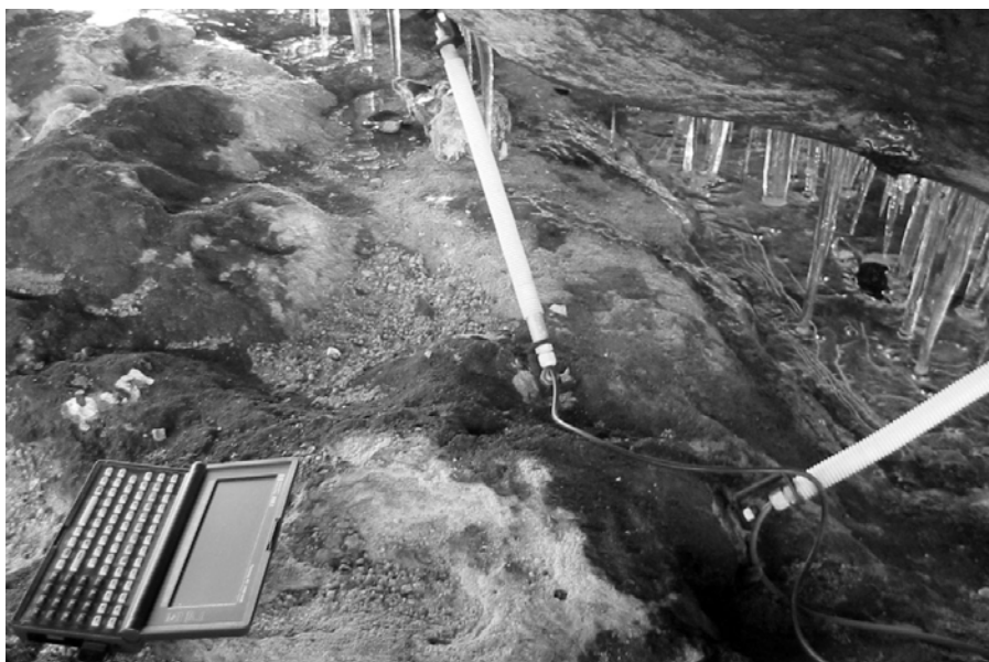
Automatický kontrolní monitoring tělesa Pravčické brány
