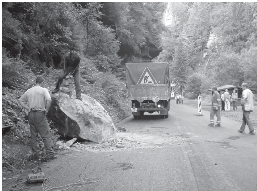
sanace parkoviště nad Klepáčem /srpen 2006/
