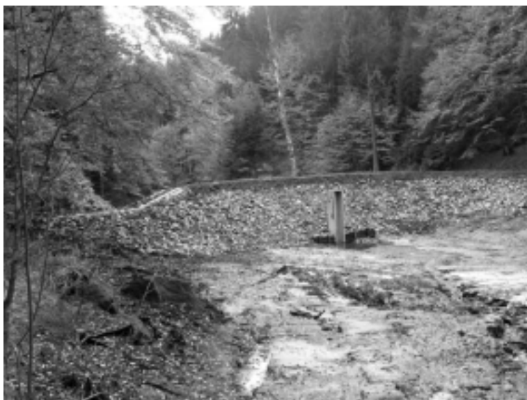
opravená hráz s novým požerákem
