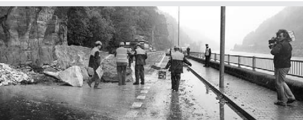
Likvidace následků skalního řícení (Hřensko, 15. 10. 2009)
