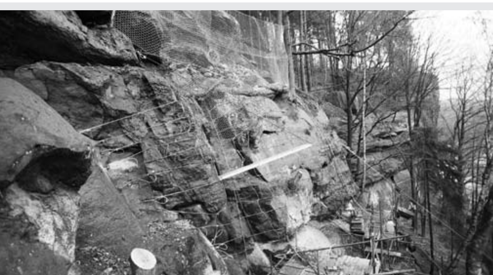
Sanace skal ve Hřensku
