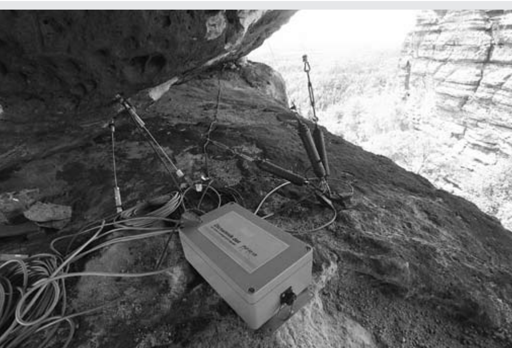
Automatický systém monitoringu na Pravčické bráně
