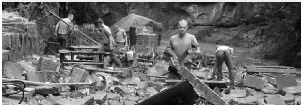
Odklizení následků srpnové povodně v soutěškách Kamenice
