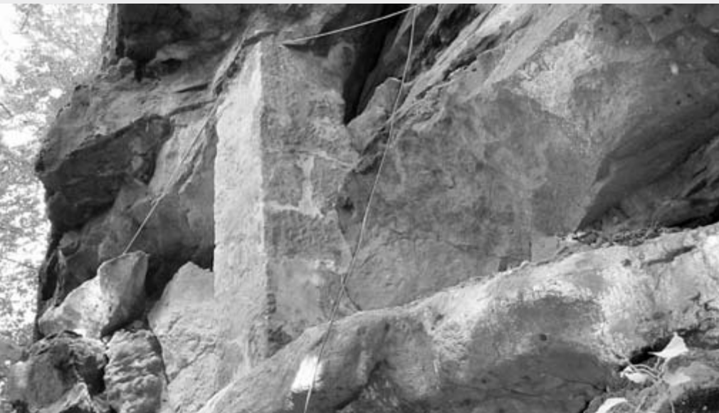
Sanační opatření nad silnicí Hřensko - Janov
