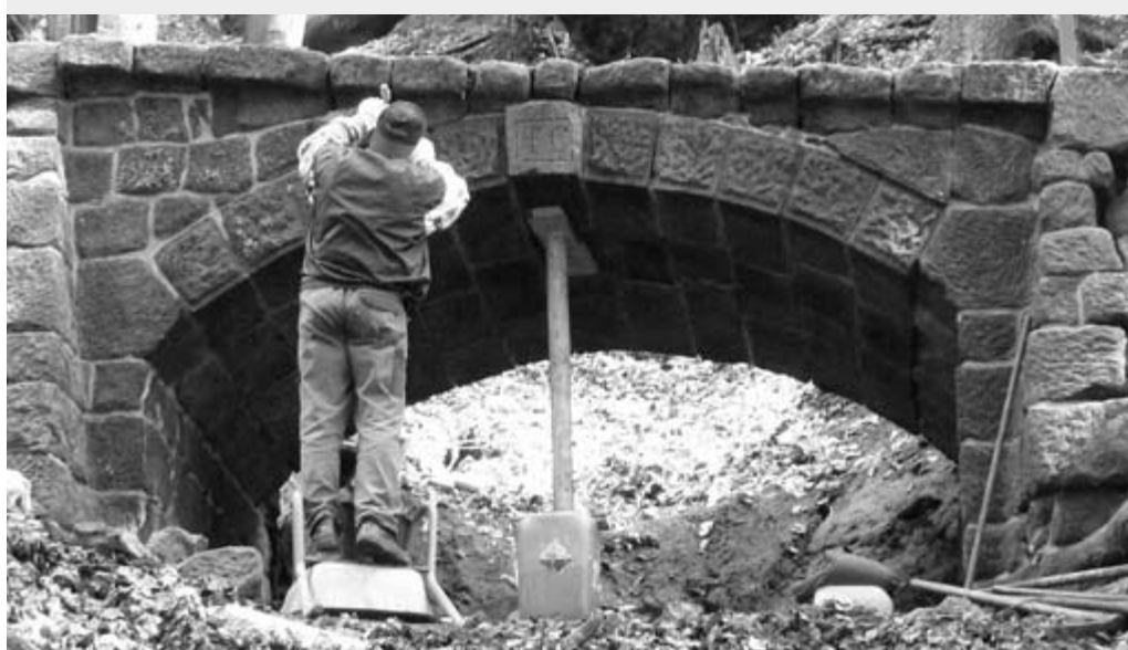
Oprava mostků pod Pravčickou bránou
