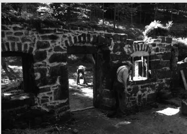
Oprava stáje u Dolského mlýnu (konzervace zdiva)
