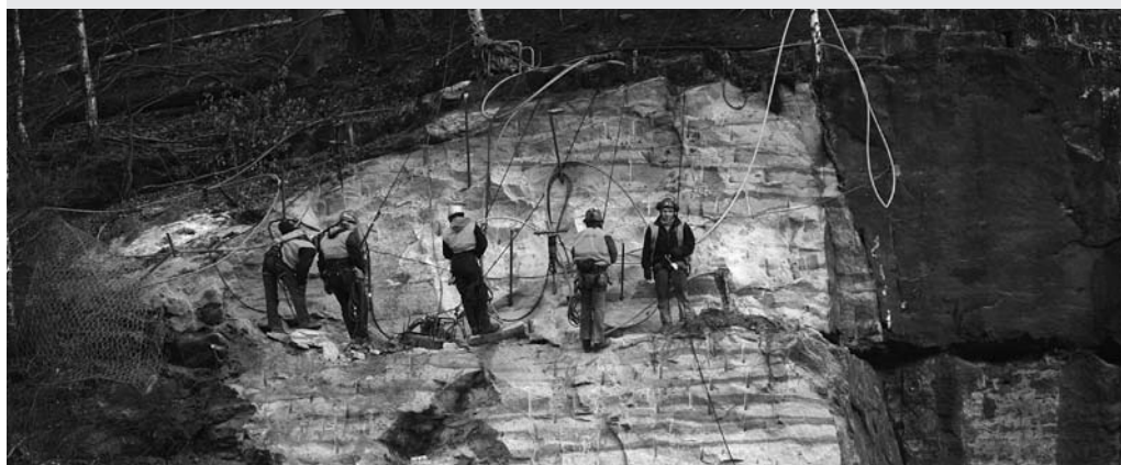
Sanace skalního masivu nad silnicí I/62 ve Hřensku
