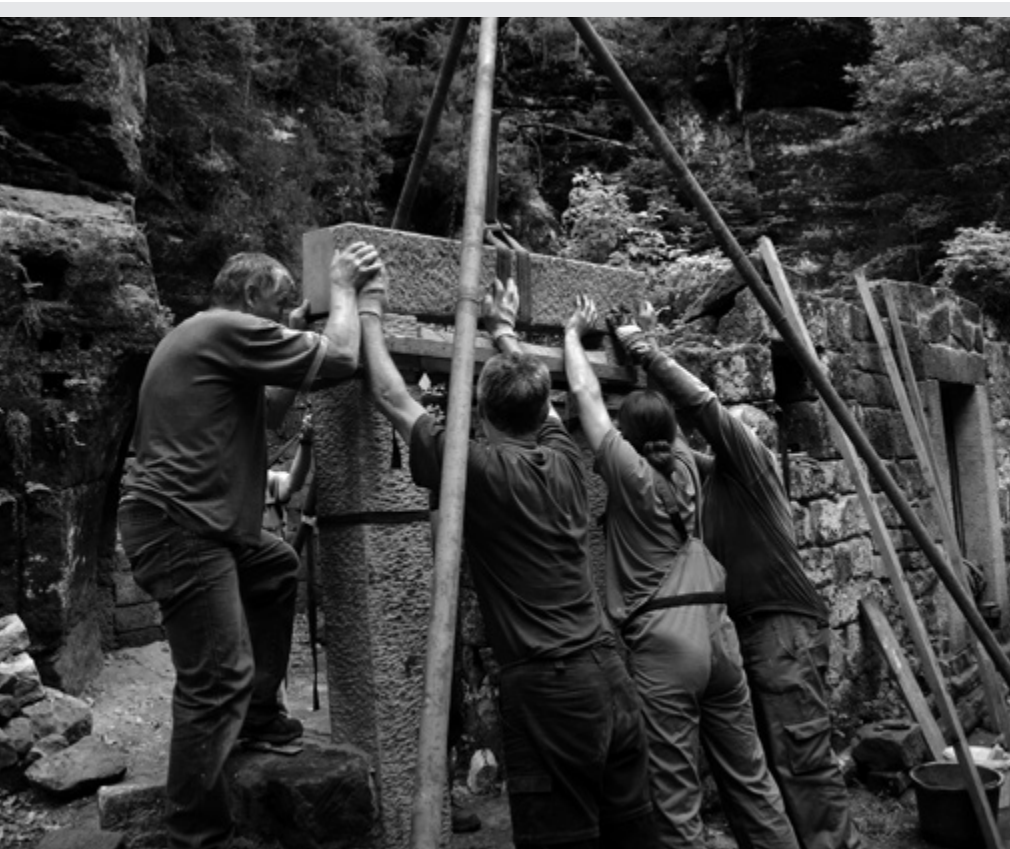
Péče o kulturní památku Dolský mlýn (osazování dveřního portálu)
