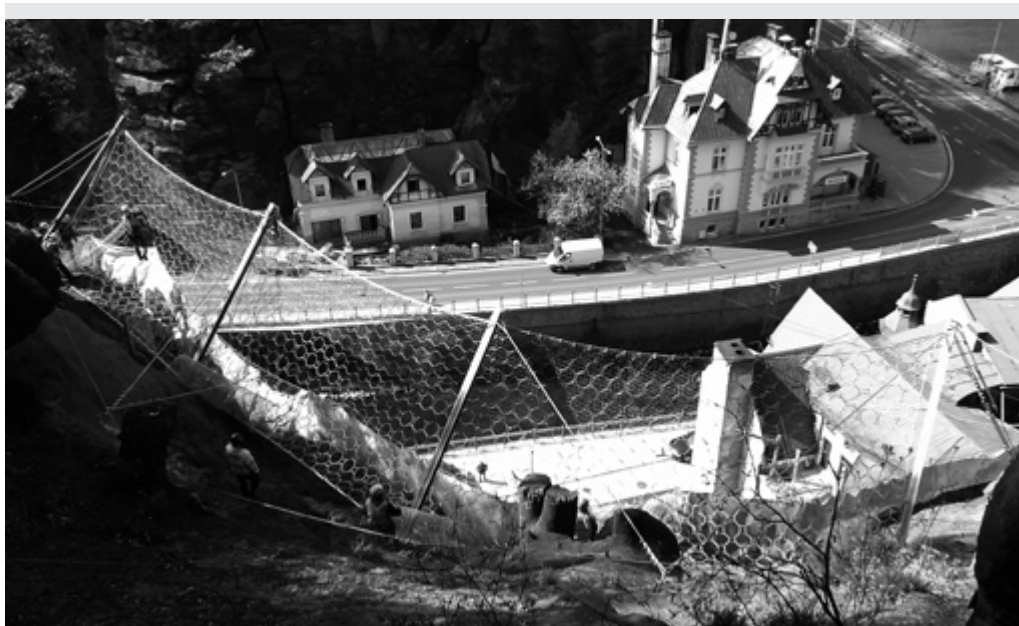
Vysokozátěžové bariéry nad obcí Hřensko
