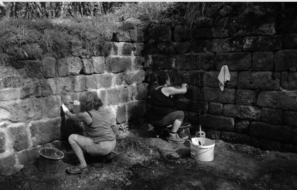
Spárování zdiva bývalé Křinické hospody v Zadních Jetřichovicích
