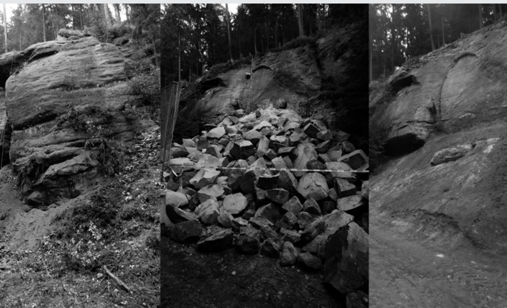
Postup sanace nestabilního skalního objektu v lokalitě Točna (před - při - po zásahu)
