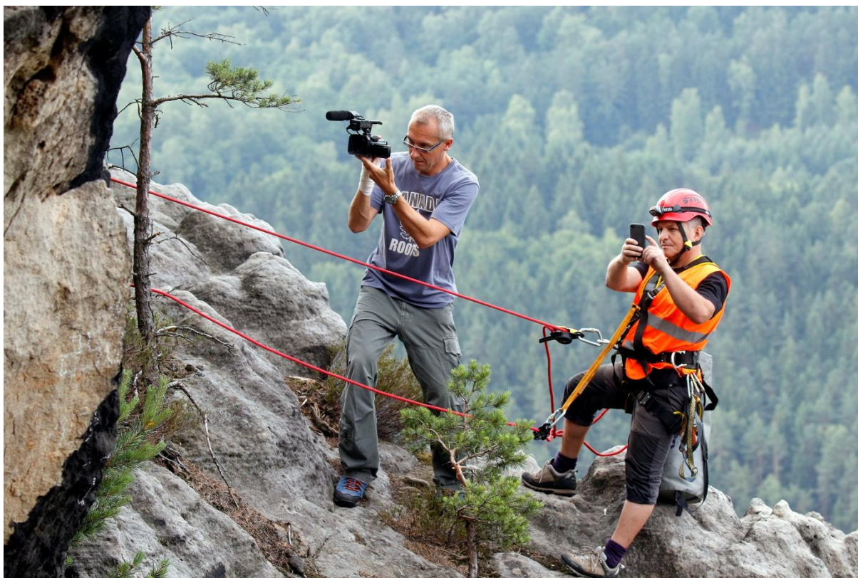
Odstranění nestabilního skalního bloku nad Gabrielinou stezkou
