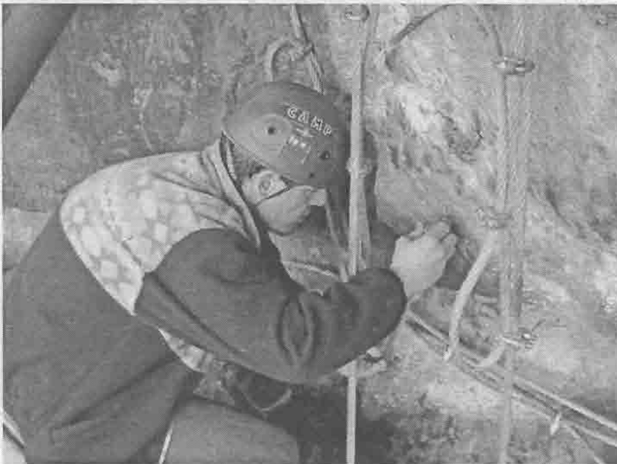
Monitoring sanovaného skalního masivu nad free-shopem v obci Hřensko
