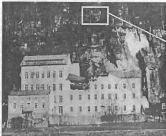
Hřensko 1936: textilní továrna byla vážně poškozena skalním řízením (400 m 3 ), dnes budova slouží jako free-shop.
