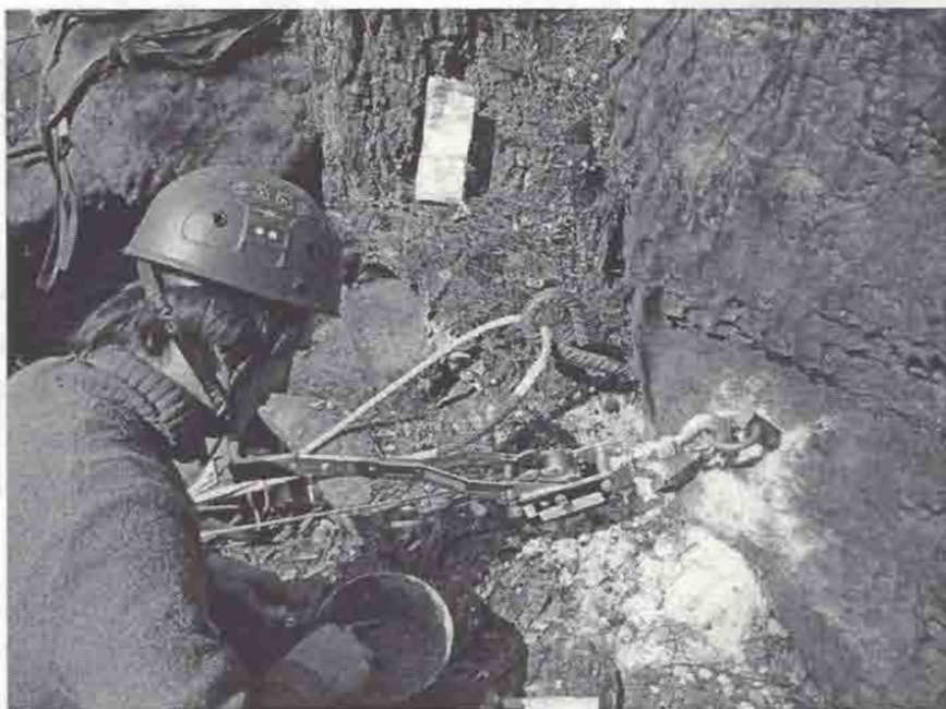
Sanační práce nad hotelem Labe ve Hřensku.
