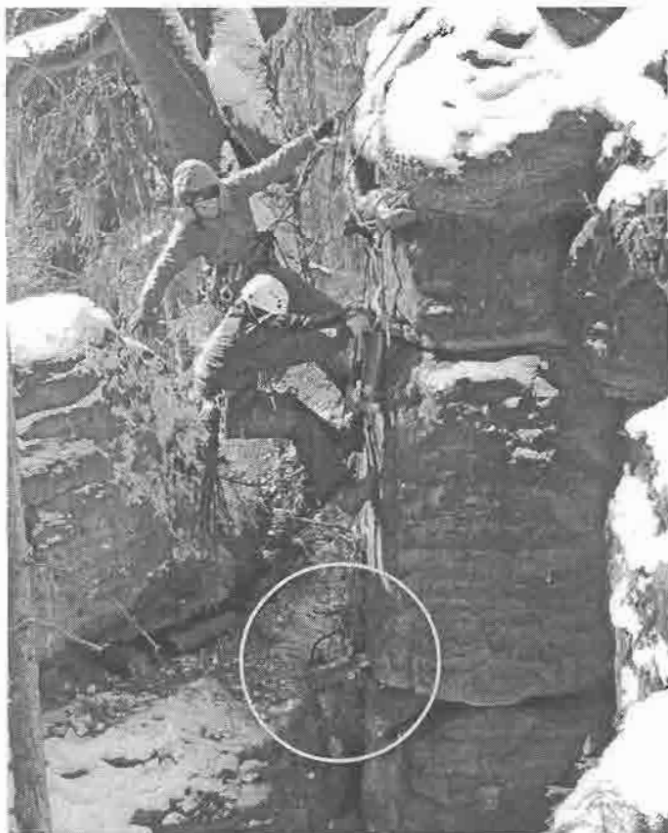
Osazení a zapojení hydraulického klínu do spáry oddělující nebezpečné bloky od pevného masívu. Foto: Z. Vařilová
