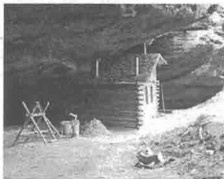
Dřevěná, dnes již neexistující stavba vybudovaná pod převisem zvaným Březák.
