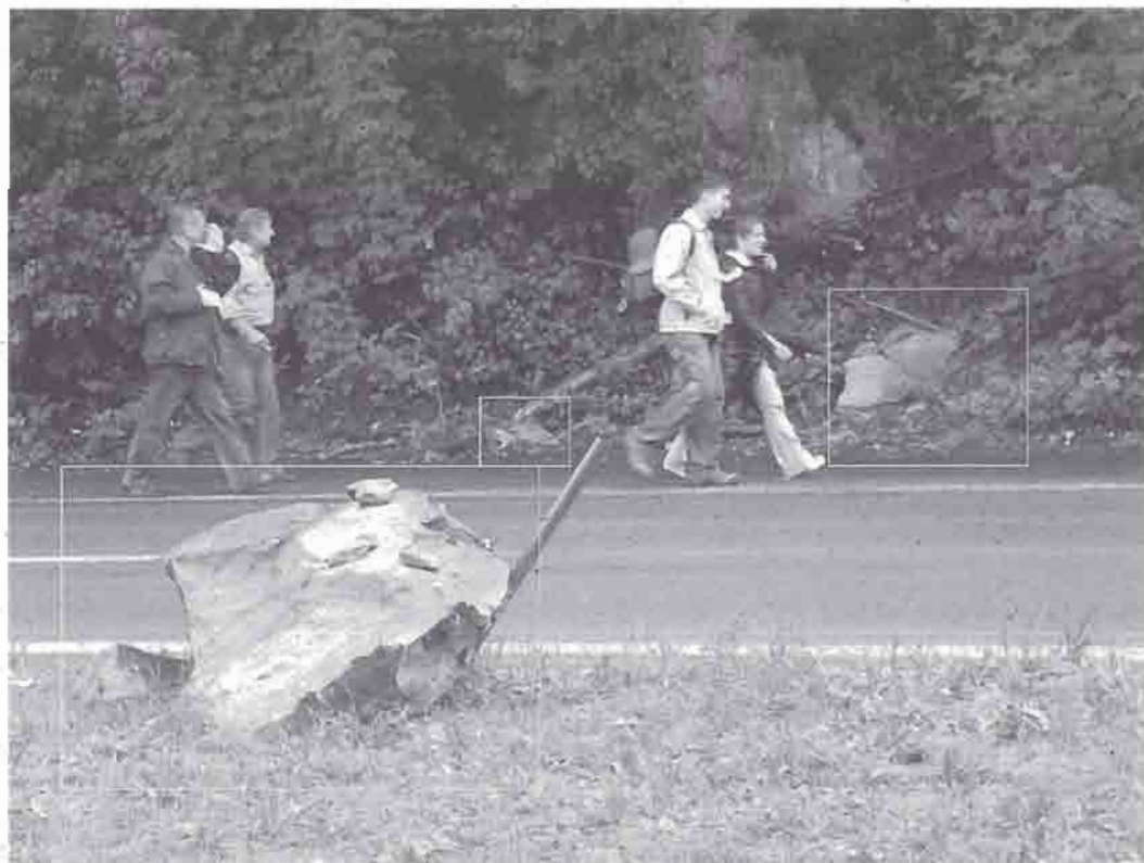
Části skalního řícení, které dopadly na mezinárodní silnici u hraničního přechodu.
