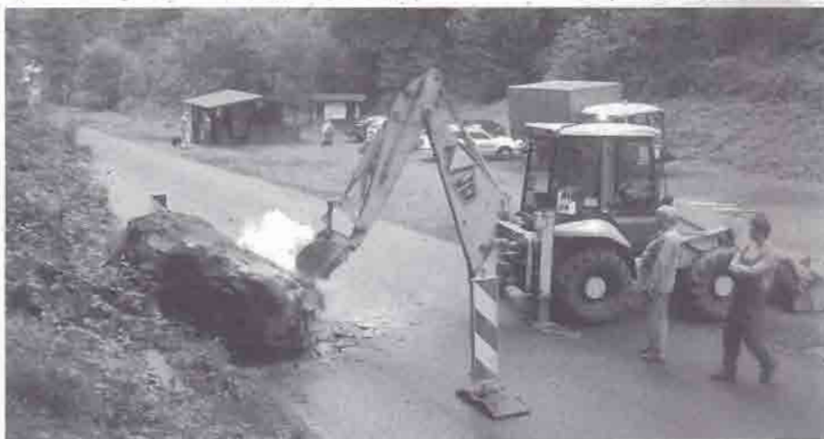
K odklizení skalního bloku o objemu 4 m 3 bylo zapotřebí těžké techniky.
