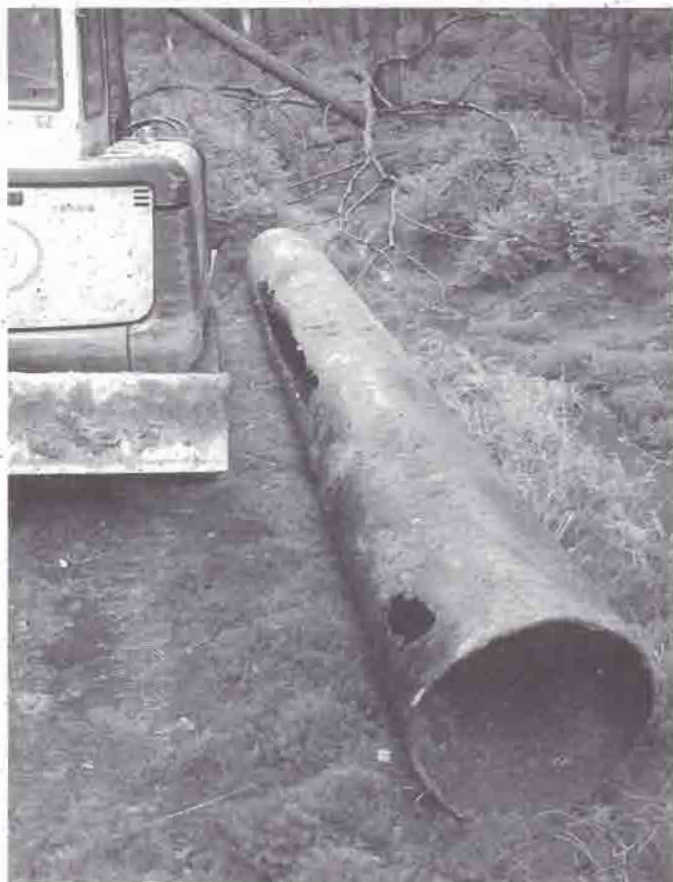
Odstraňování ocelových propustí
