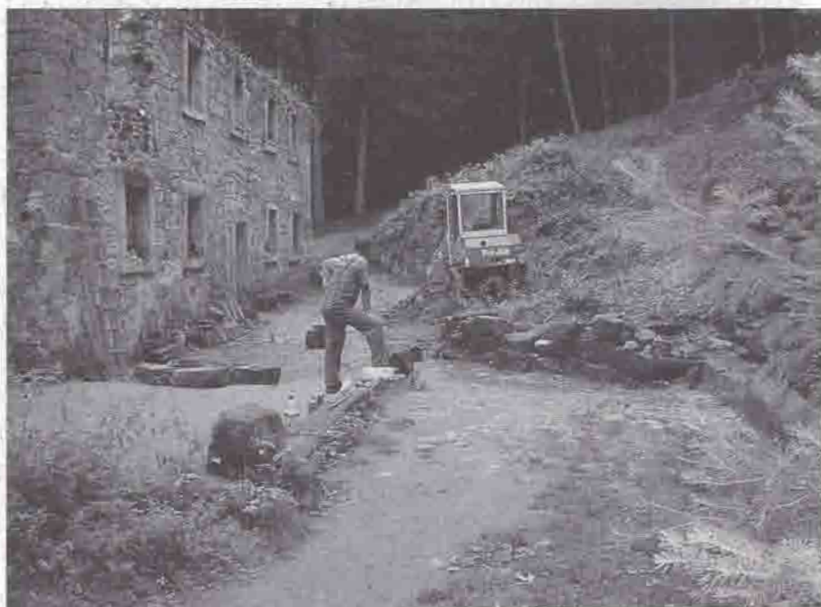
Odklizení cihlového rumiště z demolovaného hotelu
