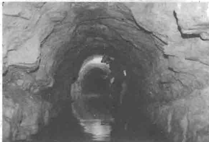
Vnitřní prostory přibližovací štoly. Foto: archiv P. Brzáka
