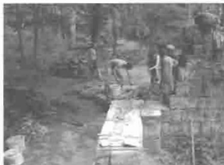
17. května - brigáda, rozebrání a přezdění kořeny narušeného nároží palírny, čištění pekárny
