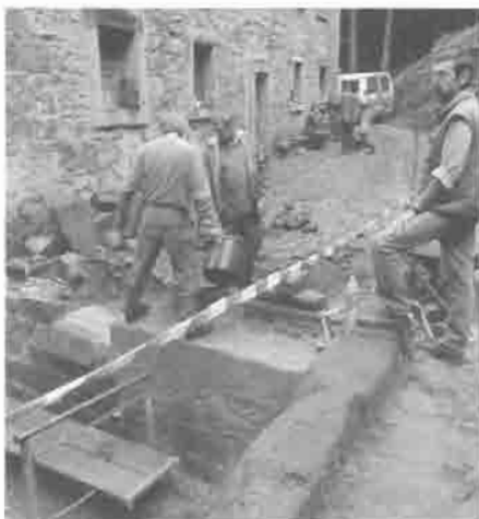
16. srpna - brigáda, odvoz vybagrovaných naplavenin z náhonu, instalace chrliče u můstku
