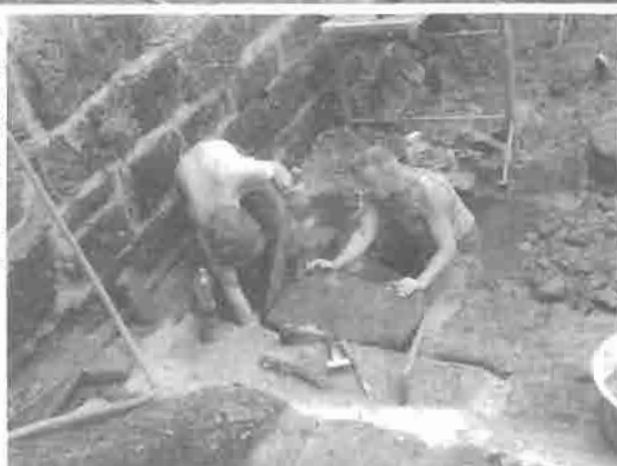
25. července - odstranění betonové desky z náhonu a následné vydláždění části čereniště, do které bude zasahovat vodní kolo. Práce provedla firma Řehák - Speleo.
