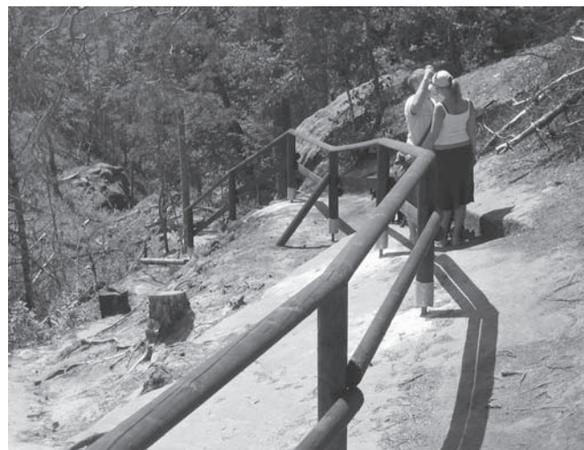
Nové zábradlí na stezce k Mariině vyhlídce.
