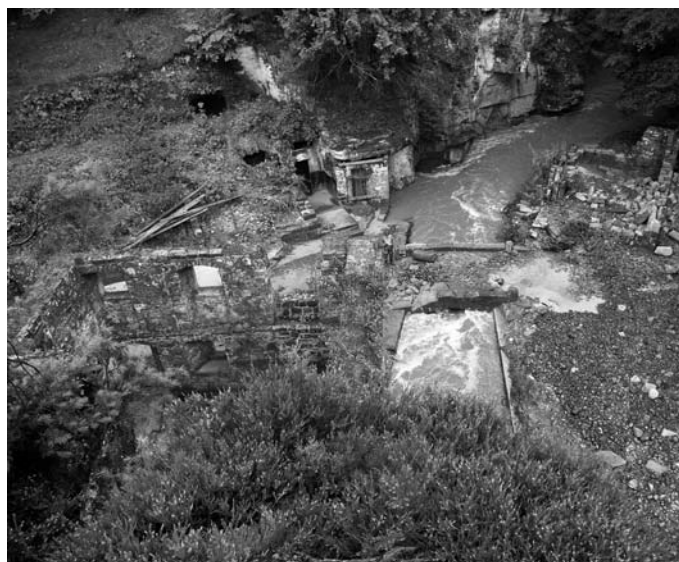
Stav po opadnutí vody.
