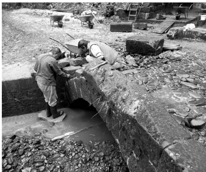
Obnova můstku přes náhon.
