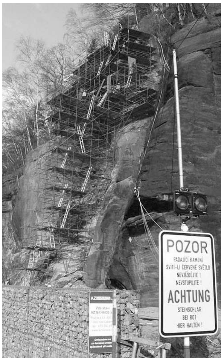
Lešení, z něhož probíhala stabilizace stěny.
