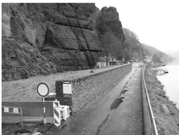
Dopadové lože s gabionovou stěnou.
