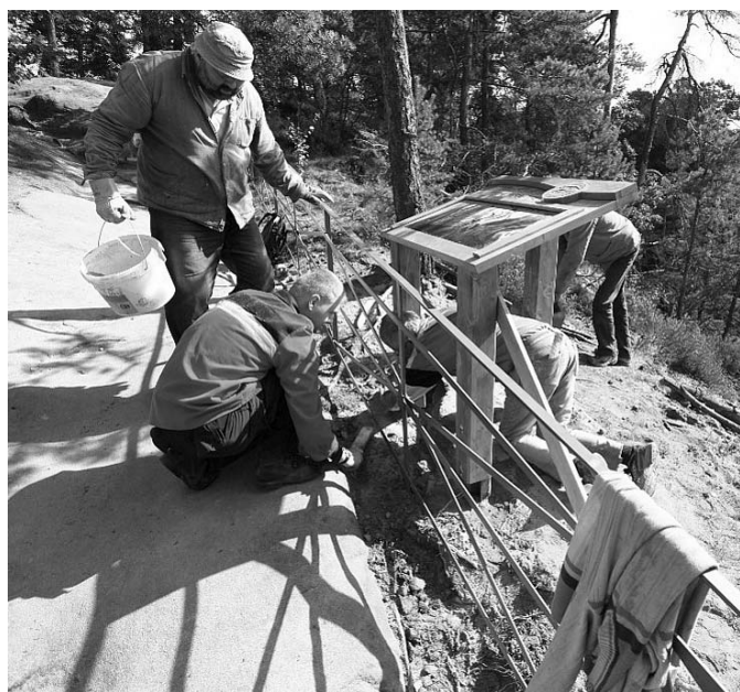
Instalace stojanu na vyhlídce na Pravčickou bránu.
