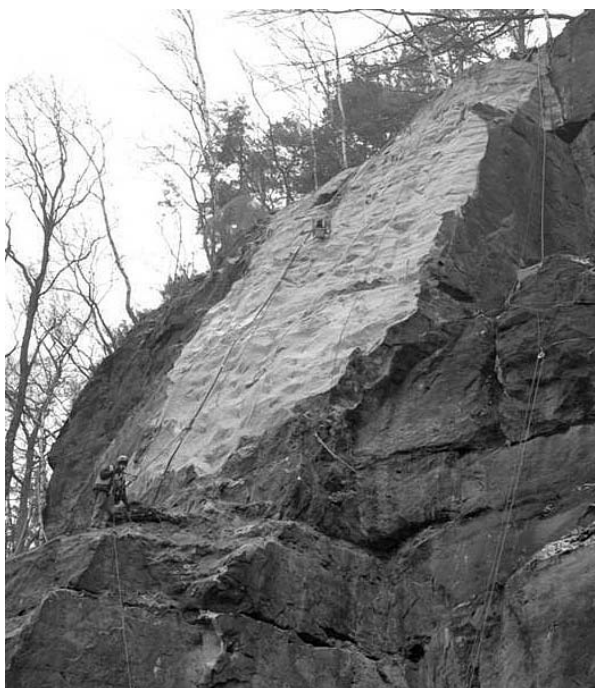
Postup sanace - odtěženo 180 m 3 horniny.
