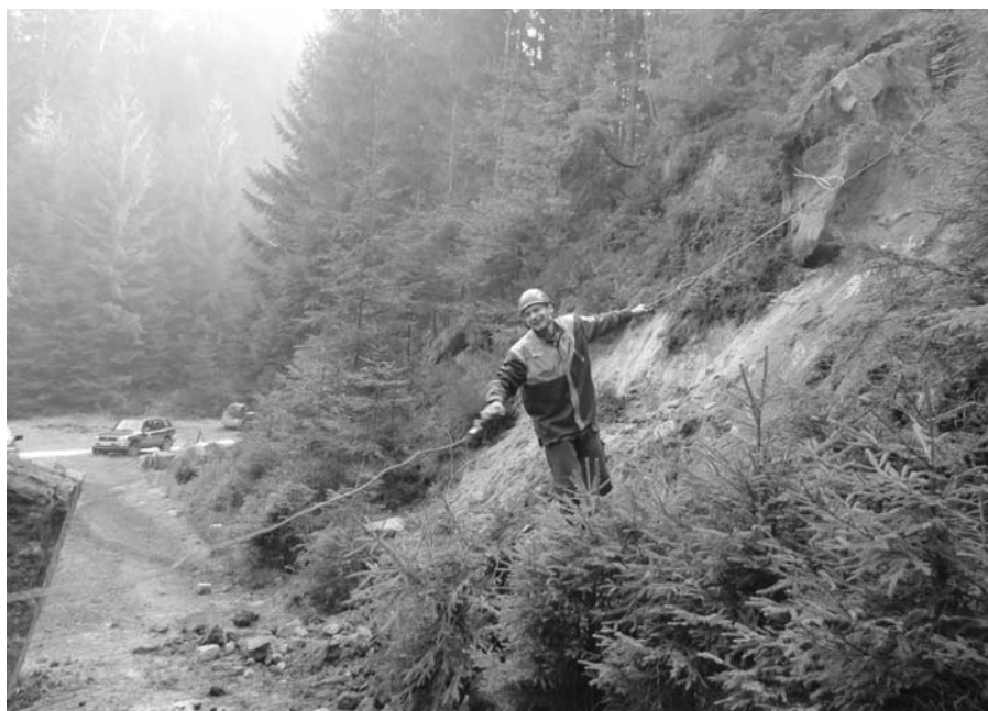
Jeden ze skaláků při shozu menších kamenů. Vlevo je místo dopadu velkého balvanu, vpravo je místo, ze kterého byl balvan uvolněn, a lano, které skalák na obrázku drží, přibližně označuje trajektorii pádu.
