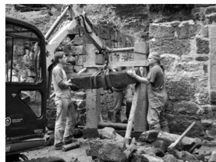
Osazování portálu stáje
