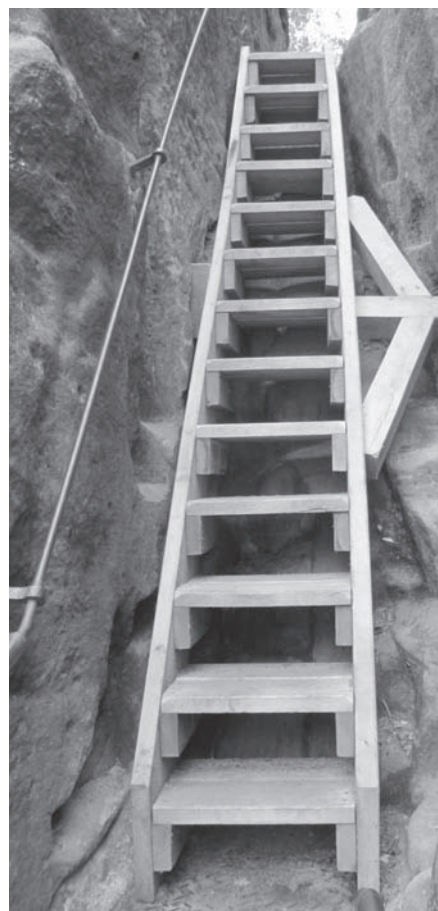
Nové schodiště na Šaunštejnu u Vysoké Lípy. Foto: Ing. Petr Bláha
