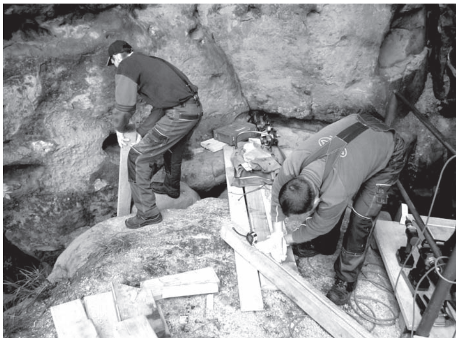
Budování nového schodiště na Šaunštejnu. Foto: Ing. Petr Bláha
