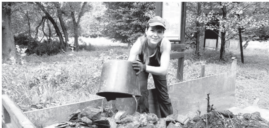
Renata Hergetová při odklizení sutí z ruin Křínické hospody v Zadních Jetřichovicích
