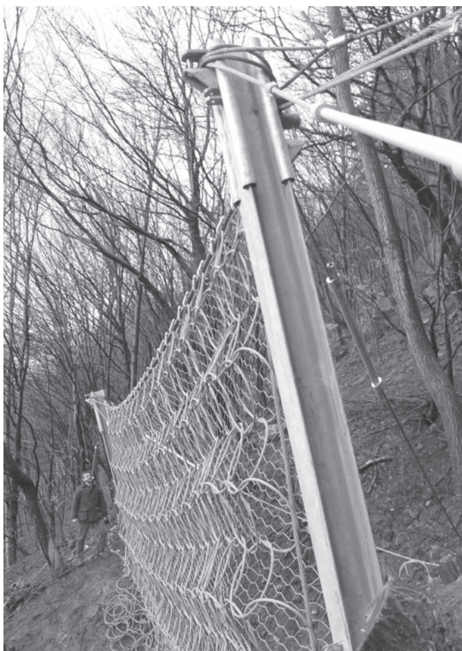
Detail nainstalované vysokozátěžové bariéry.
