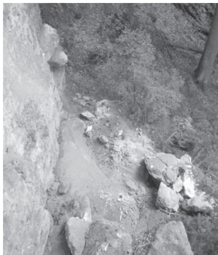
Shozené nestabilní bloky nad cestou v Edmundově soutěsce. Foto: Jakub Šafránek
