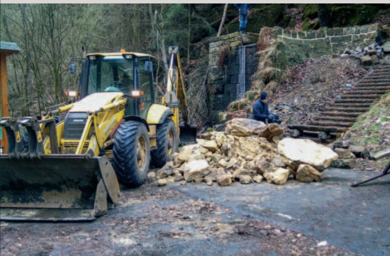
Balvan bylo nutno zlikvidovat těžkou technikou. Fota: archiv Správy NP.
