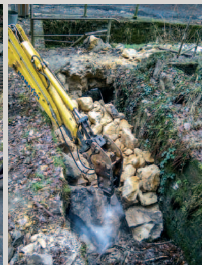
Odhadem 10tí kubický balvan zřícený do náhonu pod vodopádem ve Hřensku.
