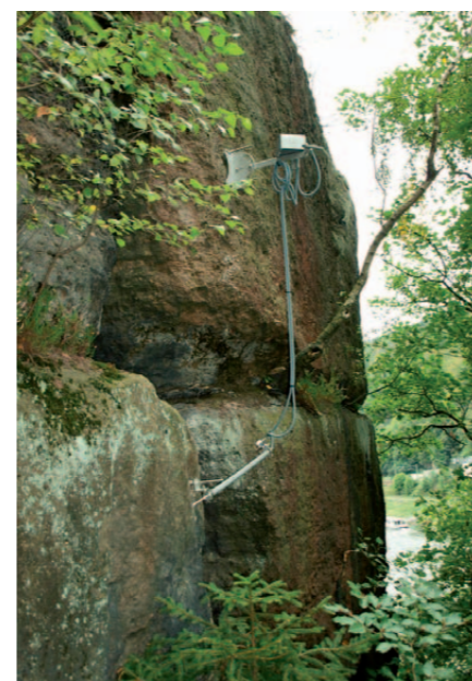
Osazení tiltmetru na skalní věži ve Hřensku.
