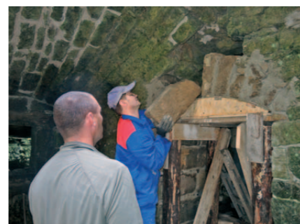
Zaklenutí průchodu v září 2019. Foto: Natalie Belisová
