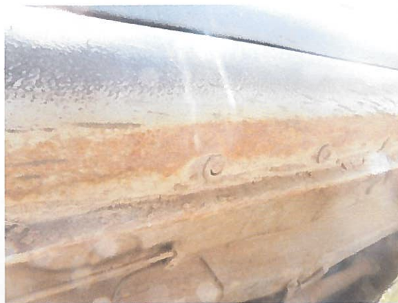
Obr. P14 – Detail koroze podlahové části karosérie
