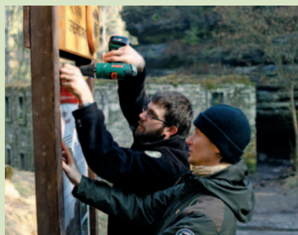
Instalace informačního panelu na naučné stezce Růžová. © Václav Sojka
