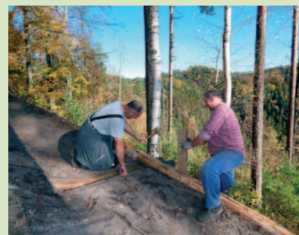
Oprava turistické cesty (zpevnění hrany). © Archiv správy NP
