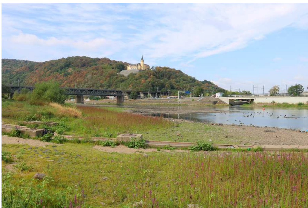
Obr. 2 Foto: Náplav v Ústí nad Labem, Střekově, 15. 8. 2018 (E. Volfová)
