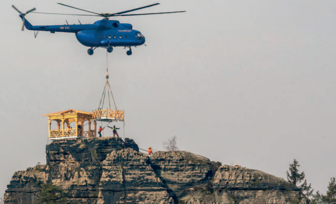
Instalace nového altánu v únoru 2021. © Václav Sojka
