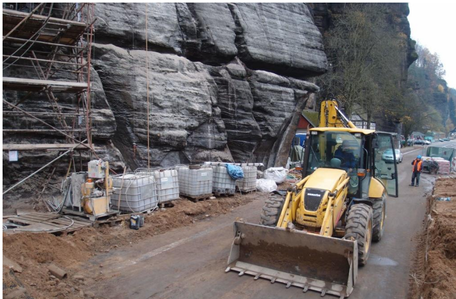
Odklizení dopadového lože
