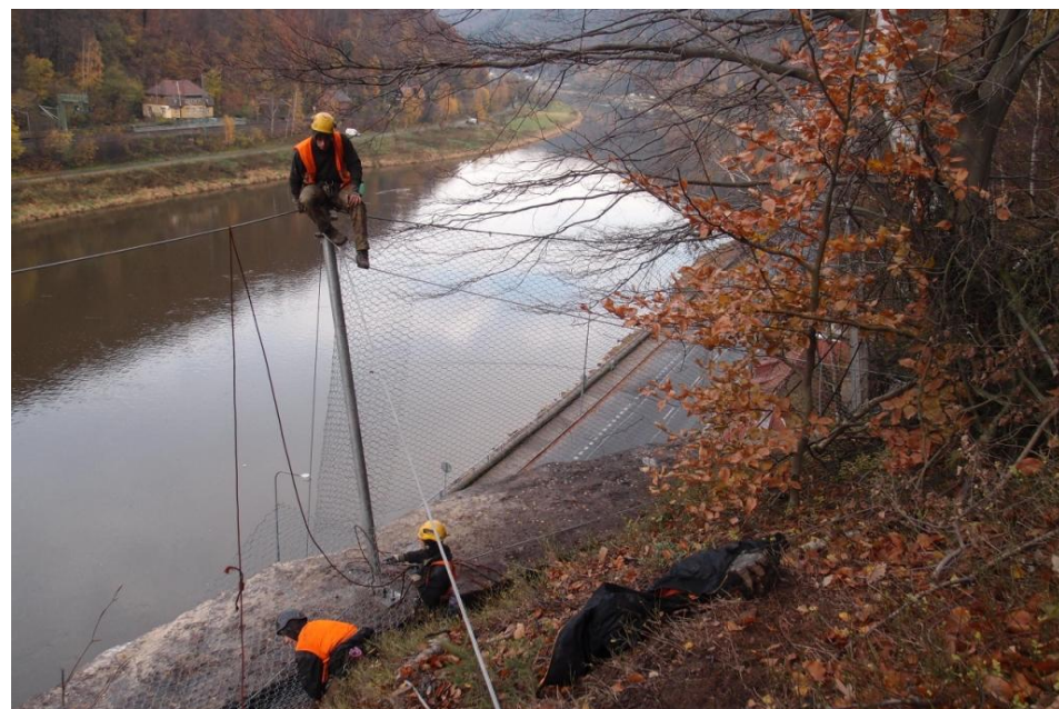
Budování dynamické bariéry
