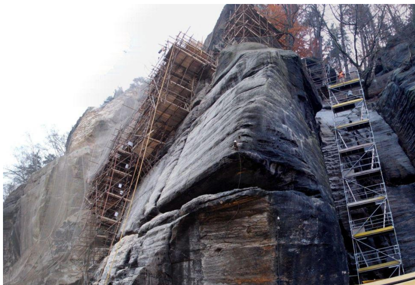
Těžké pracovní lešení, lehké přístupové lešení
