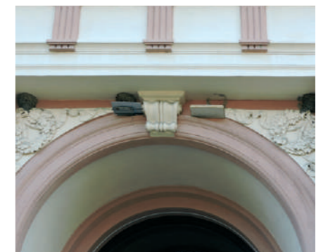
Hnízda nad vchodem školní budovy v Dolním Podluží, kde pod ně pan školník umístil podložky. © R. Procházková
