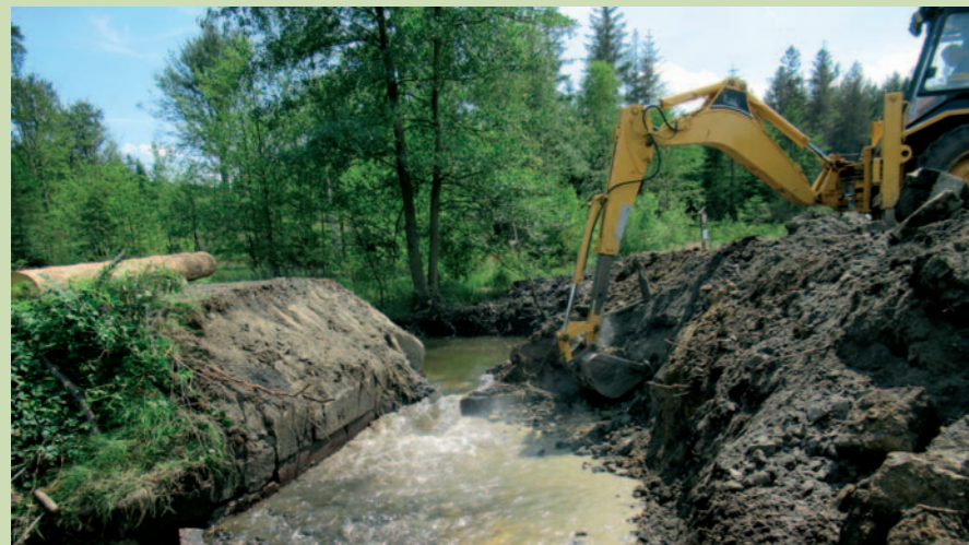
Prokopáním hráze Královomlýnského rybníka se podařilo předejít jejímu protržení. © Petr Bauer
