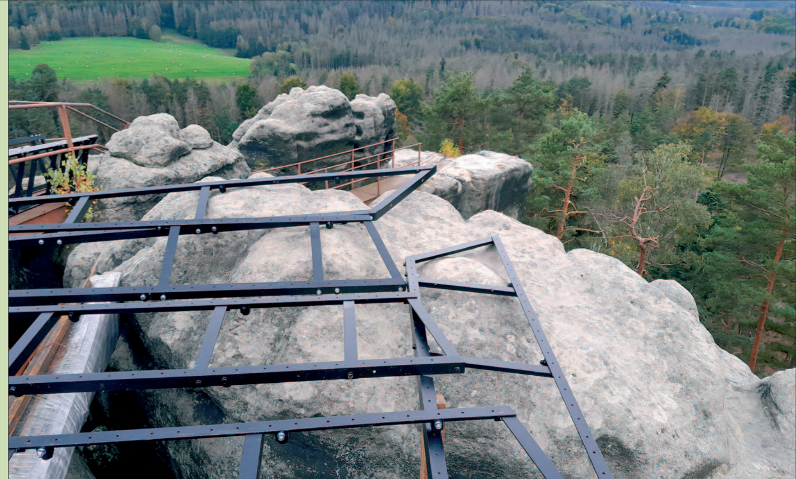
Sestavování dílů nových nosných konstrukcí na Šaunštejně. © Pavel Svoboda
